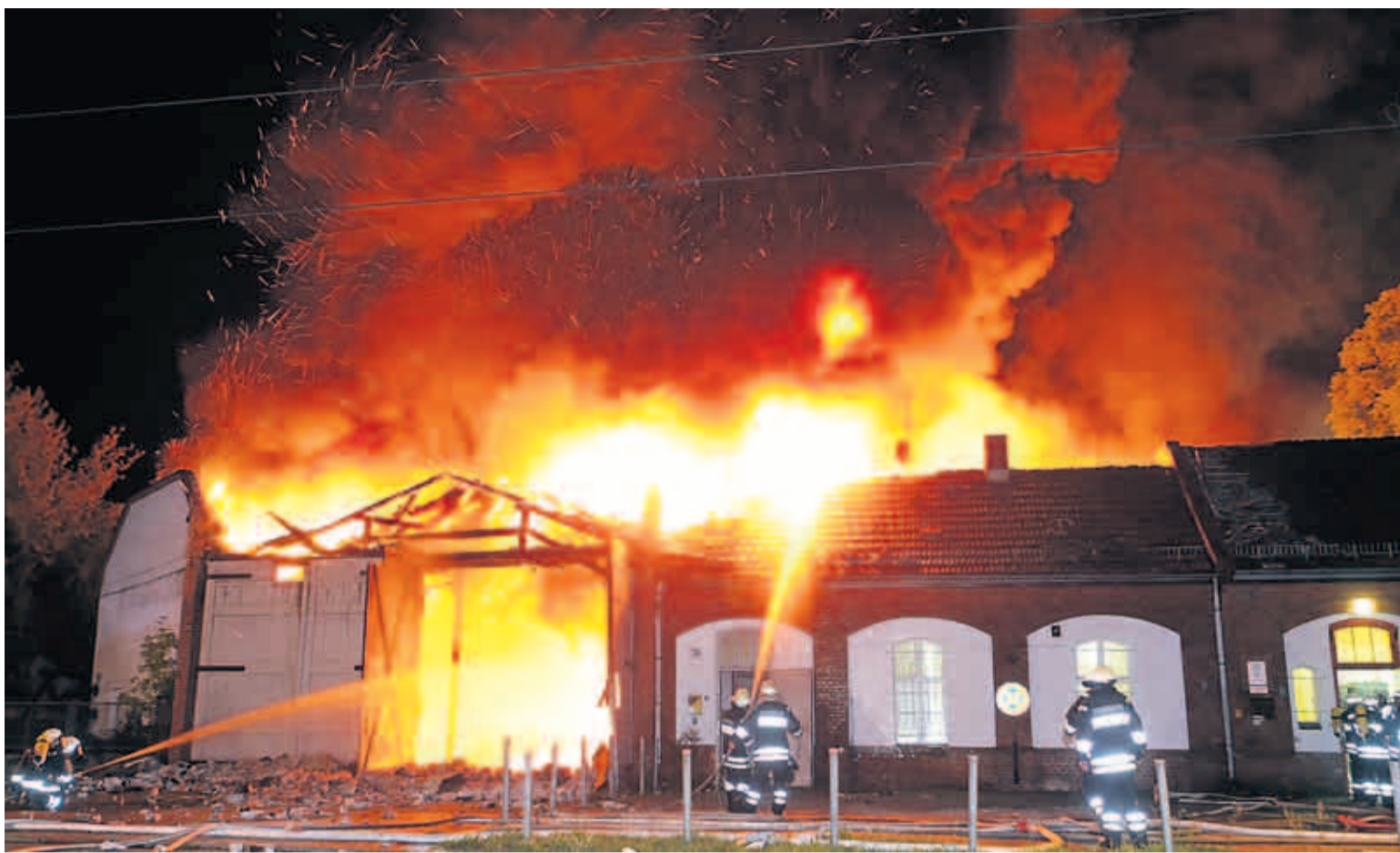
Die Flammen schlagen meterhoch aus dem Dachstuhl der Lagerhalle in Schmöckwitz
